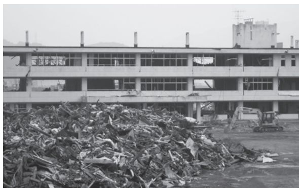
津波により損壊した陸前高田市立気仙中学校 (6月5日撮影 岩手県陸前高田市)
