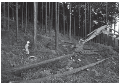
▲紀北中学校建築用材の伐採
