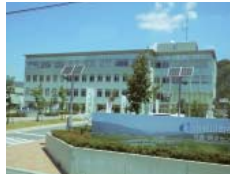
揖斐川町役場
